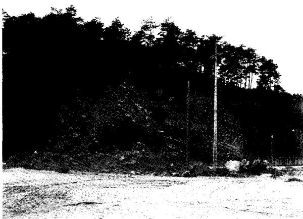
사진 4. 성산면 송암리 안송암 암반사면 파괴모습
