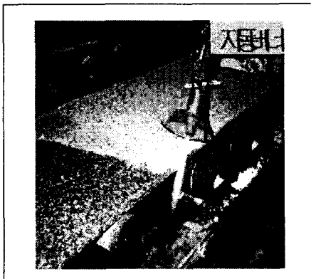
<그림 2> PLC 자동버너작업
