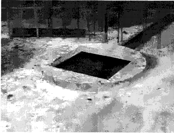
〈그림 14〉 강재 집수정 설치 사례
