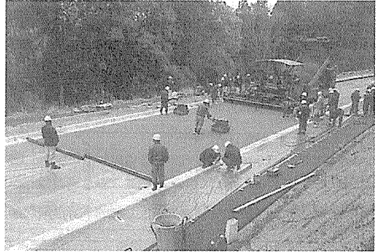
에코시멘트를 사용한 포러스콘크리트 포설
