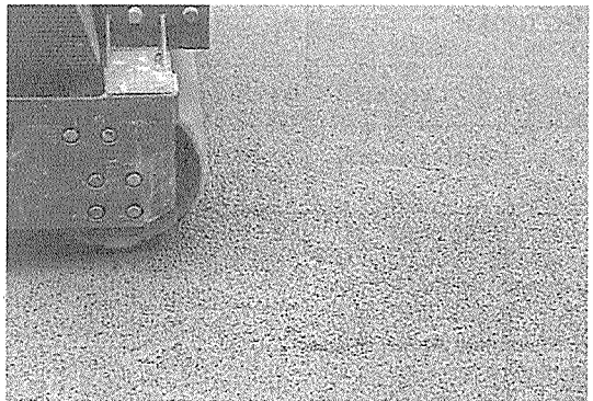
포러스 콘크리트 포장면
