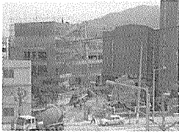
[사진 3] 콘크리트 부어넣기
