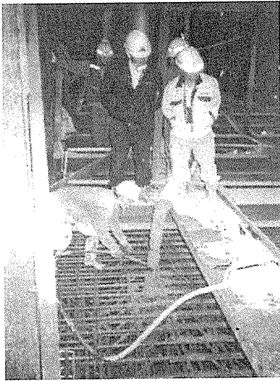
[사진 1] 현장콘크리트 타설 전경
