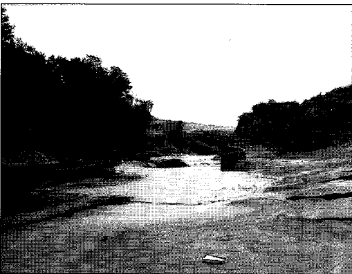
강릉 장현 저수지 여수토 방수로 붕괴
