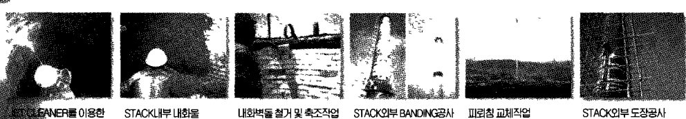
ET CLEANER를 이용한 STACK세정작업 STACK내부 내화물 코팅작업 내화벽돌 철거 및 축조작업 STACK외부 BANDING공사 피뢰침 교체작업 STACK외부 도장공사
