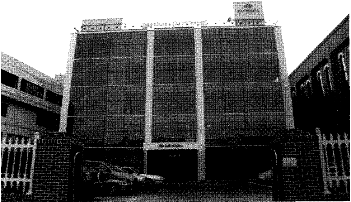
▲(주)한영전자 회사 전경
