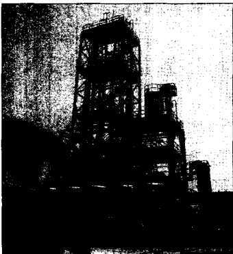
[ 그림 2 ] 안산 (주)진로발효 공장내에 설치한 연료용 알콜생산 Pilot Plant(생산능력 300kl/년)
