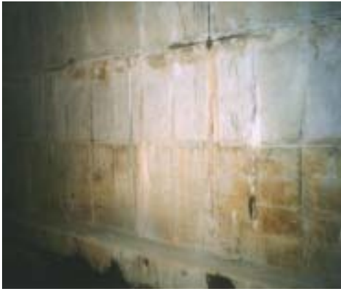
Photo 6 배면지수그라우팅 현장시험시공 시공 후
