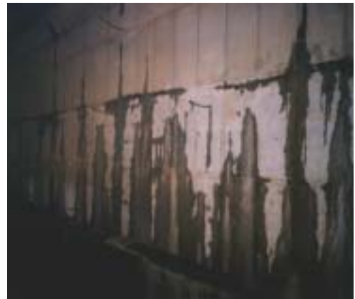
Photo 5 배면지수그라우팅 현장시험시공 시공전
