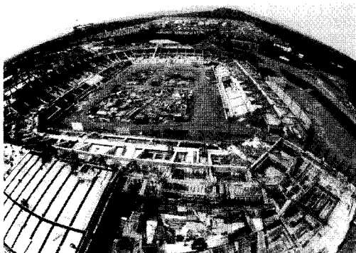
사진 9. deck slab 설치 모습
