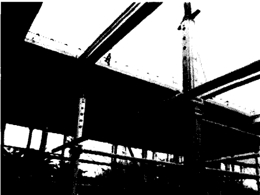
그림 28. 하프PC 슬라브 설치
