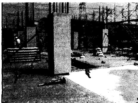
그림 21. 기둥 거푸집 설치후 가설재 설치
