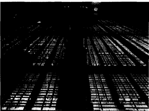
그림 29. 슬라브 철근 설치
