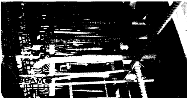
그림 19. 철근 COUPLER 설치
