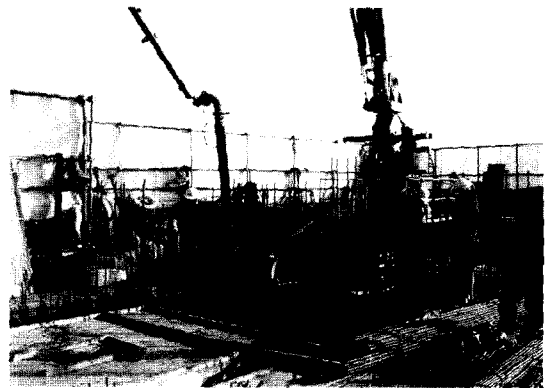
그림 10. CPB를 이용한 콘크리트 타설
