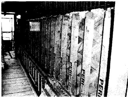
그림 12. 열선 및 보온재 설치 전경
