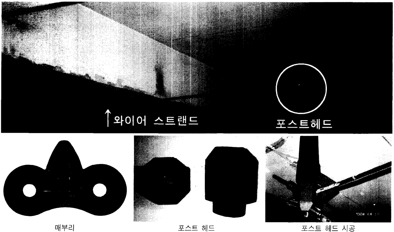
그림 2. 양 방향 트러스를 이용한 구조 보강
