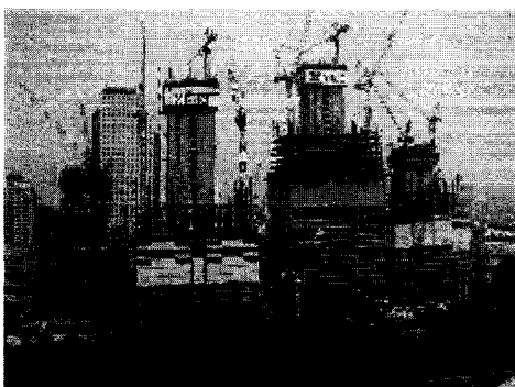
<타워패리스 1차현장 공사전경 -양쪽면에는 ACS Form, 가운데 2동은 Slip Form을 적용하였음>
