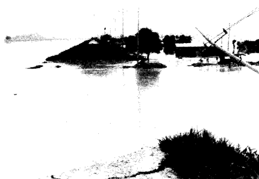
사진 4. 1983년 집중호우로 인한 피해 사진 (금강 삼호제방 유실현장, 충청남도 논산군)
