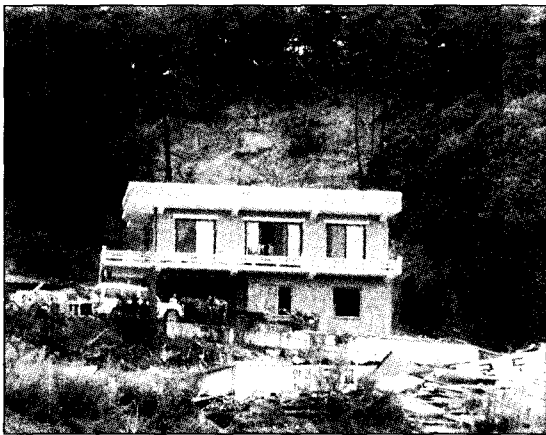
그림 7. 피해가 미미한 콘크리트 벽돌 주택
