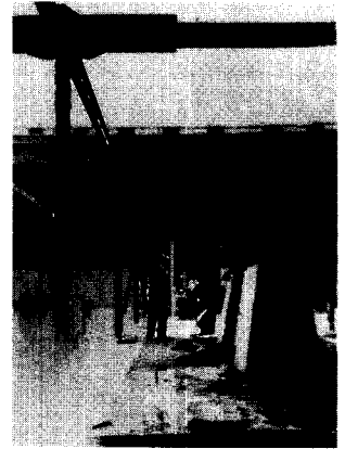
<그림 13> 1929년 당시 바로셀로나 파빌리온의 기둥-보 공사 사진
