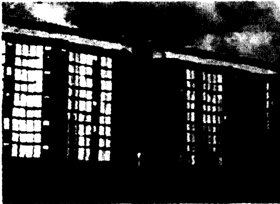
(c) 중층건물(학생기숙사, Univ. of Strathelyde, Glasgow, 영국) 투과형단열재(PC 허니콤 타입, 두께 10 cm) - 에너지절감량: 일반건물에 비해 약 40% 절감 - 벽 전체의 열관류율(일사 배제): 0.6 W/㎡K
