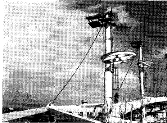
그림 17 Diagonal Backstay Cable 설치
