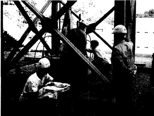
그림 19 Backstay Cable 1차 인장
