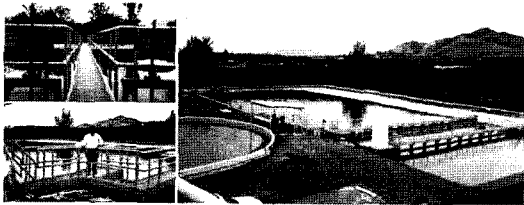
그림 18 Waste water treatment facility
