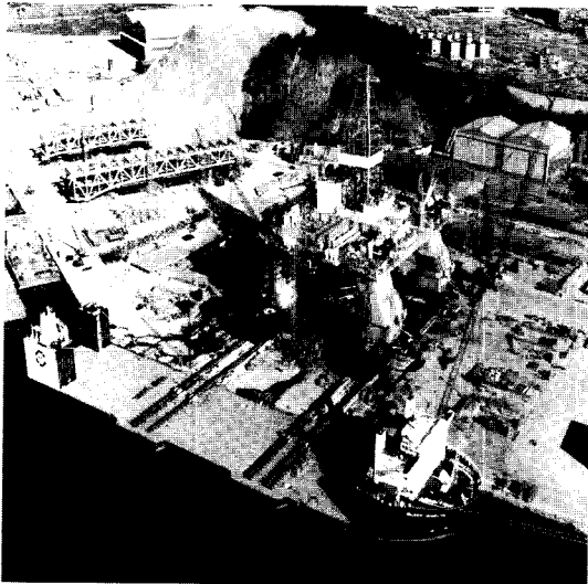
Fig. 2 Deepwater Nautilus : Loadout
