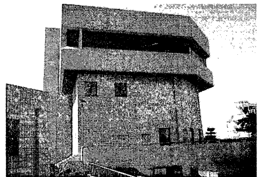
Fig 4. 평택 중앙조정실 건물 측면.
