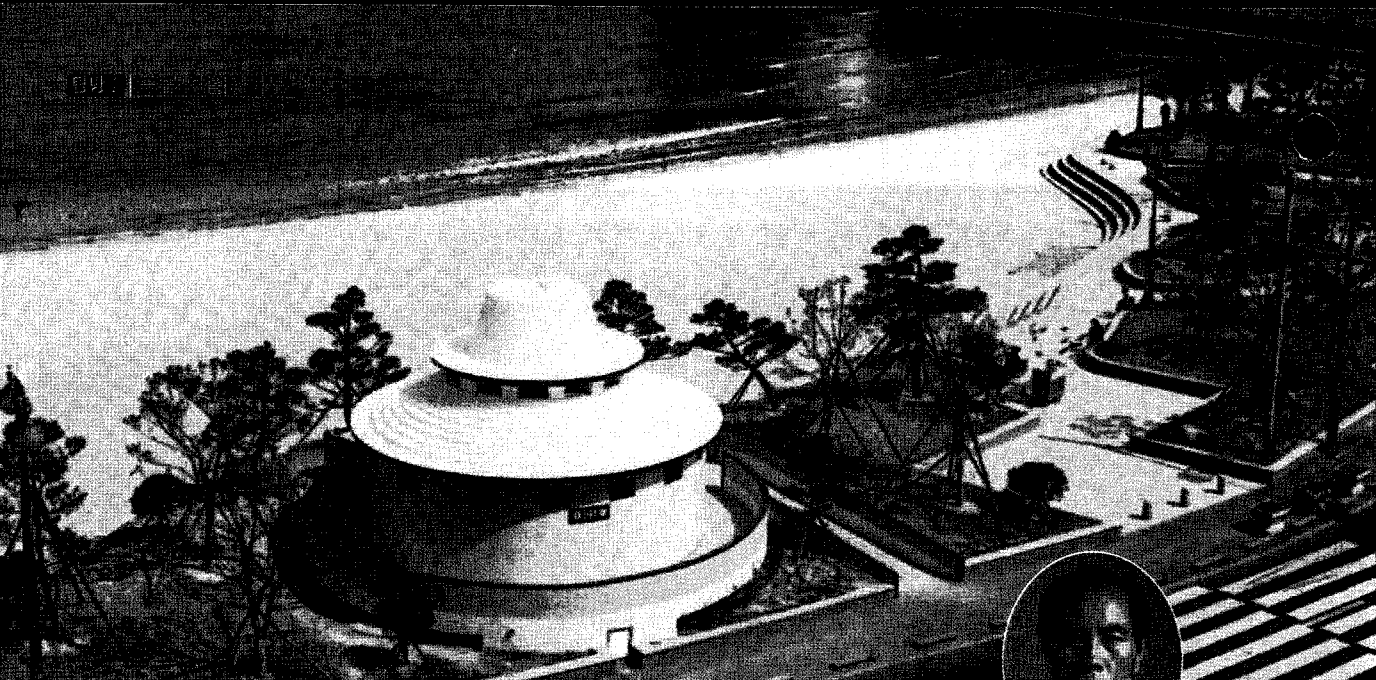
부산 광안리 제2해수욕장 화장실 전경
