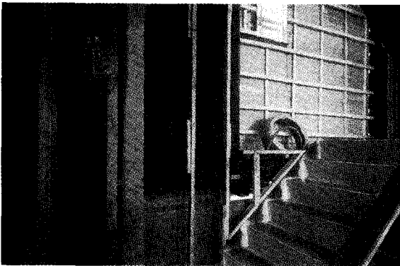
2층과 3층을 연결하는 계단주의. 내진벽이 상하로 어긋나 있는 것을 알 수 있다.
