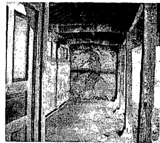
사진 8. 경덕단 외삼문 내벽의 內觀
