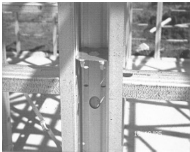
그림 8. Tab-in-Slot 방식(1)
