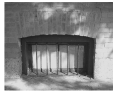
사진 11. 포사이드 기념주택 밑숯음평아치 지하실창문
