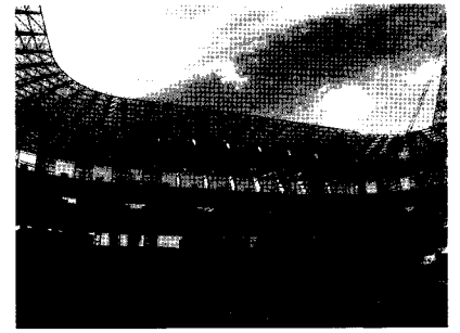
그림 27. 지붕트러스 설치후 전경(내부)
