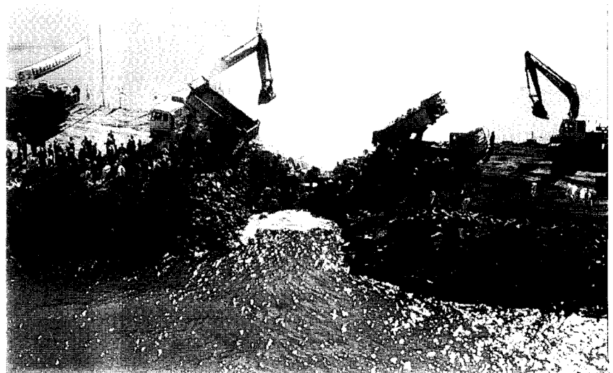
사진 1. 바다를 둘로 가른 방조제 끝막이 공사
