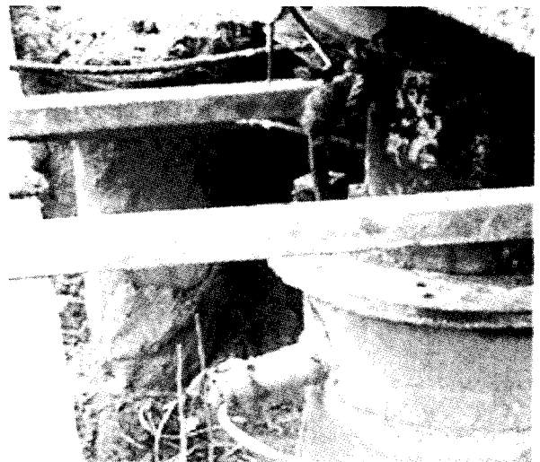
그림 12. 광섬유 격자 센서가 내장된 말뚝을 중계동 아파트 공사장에 설치한 모습
