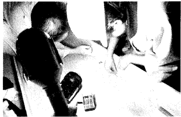
그림 10. 남해대교 내부에 광섬유 격자 센서를 부착하고 있는 모습
