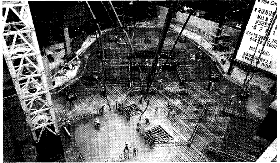
사진 2. 다짐 작업없이 콘크리트를 타설 하는 모습
