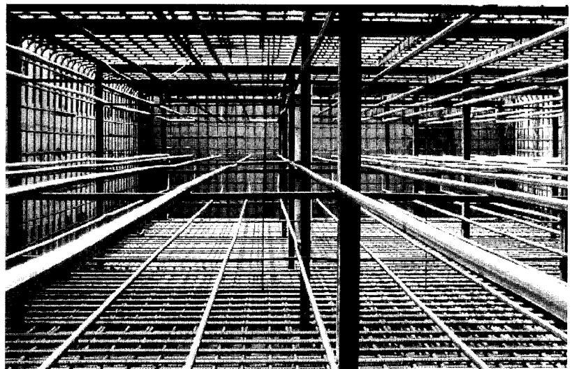
사진 3. 파이프 배관 전경
