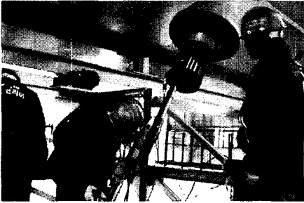
사진 3. 모노잭을 이용한 마스터 스트랜드 긴장
