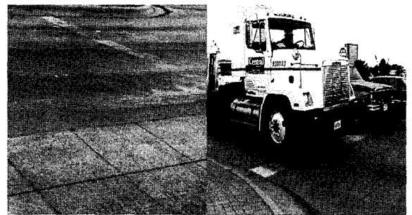
그림 2. UTW 시공 후 모습
