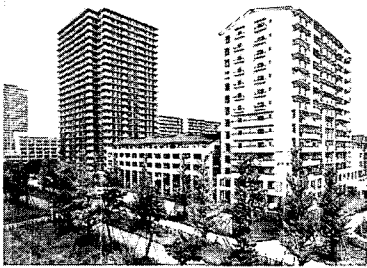
사진 10. 단독 부재 방식에 의한 전체 프리캐스트 초고층 주택 (히카리 언덕 B14호동)
