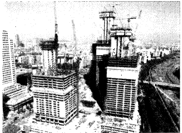
그림 3. 타워몰리스 지상층 공사 전경
