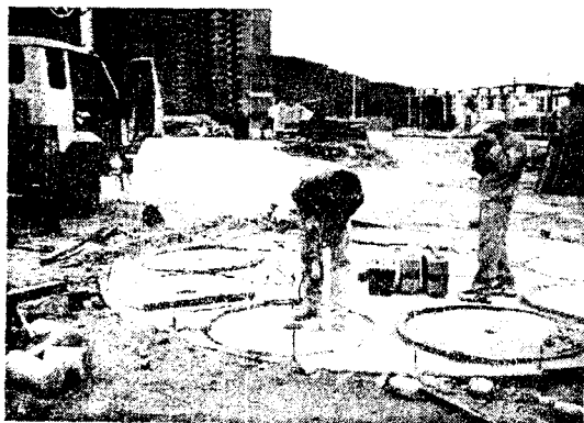
그림 5. 17mm 직경의 비트를 사용한 시험발파공의 천공
