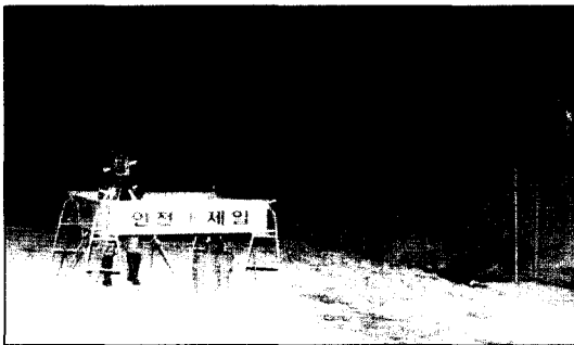
그림 12. 터널내공단면을 측량하는 모습
