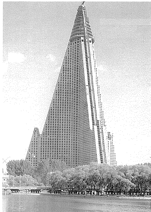
유경호텔: 북한에서 가장 높은 건물 (105층)로, 경제난으로 공사가 중단되었다고 한다. 백두산건축설계원 작품으로, 북한의 경제적 수준 에 비춰볼 때 철근 콘크리트조로 이런 초고층건물을 설계하고 시공 할 수 있다는 게 아이러니 하다.
