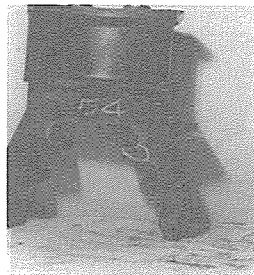
【사진-3】 고압1단 블레이드 Hook부 균열
