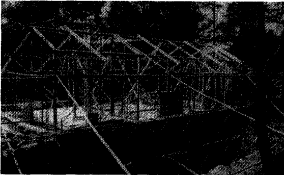
2층 지붕은 목조, 건물몸체 재(材)와 수목으로 모양을 결정함과 동시에 샷시의 벽 허리 부분의 C판넬을 설치한다.
