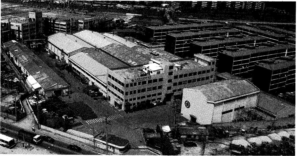
▲ 삼아알미늄 가공공장 전경
