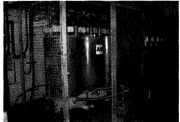
〈그림 1〉 운용중인 ABB의 고온초전도 변압기(1997). 절연유를 전혀 쓰지 않으며 효율이 상전도 기기에 비해 약 1% 높다.
