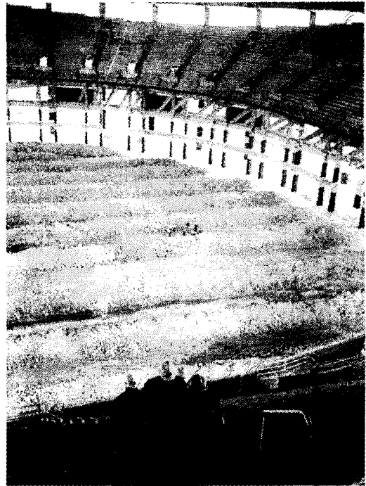
사진 2. 충격완화를 위해 바닥에 쌓은 소단들의 모습
