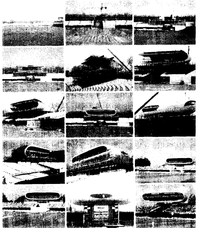
그림 4) 1994년에 완공된 퓨쳐시스템의 크레킷 구장의 Lord's Media Center. 조선소의 독에서 미리 제작되어서 구장에 조립되고 있는 모습. 건축기술의 차용적 방법론.
