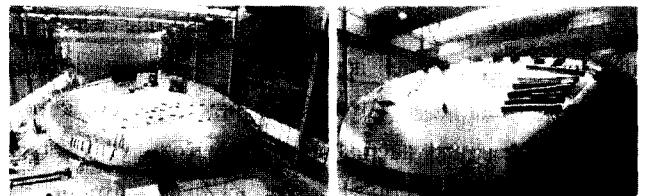
<그림 2> 로이드 빌딩의 화장실 유니트의 조립 장착 모습. 아쉽게도 한번 장착된 각 단위들은 영구한 건축부품으로 남게 되어 건축물 부품들의 재활용적인 측면을 지니지 못하게 된다.
