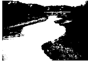
(b) 공사 후 첫 강탁 유량(1999)
