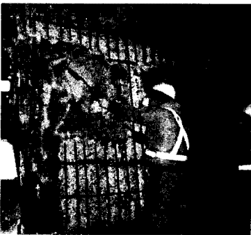
사진 12. 알카리성 부여제 도포
