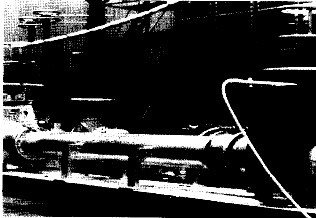
그림 7. 154kV 800MVA급 극저온 저항케이블 송전시스템
