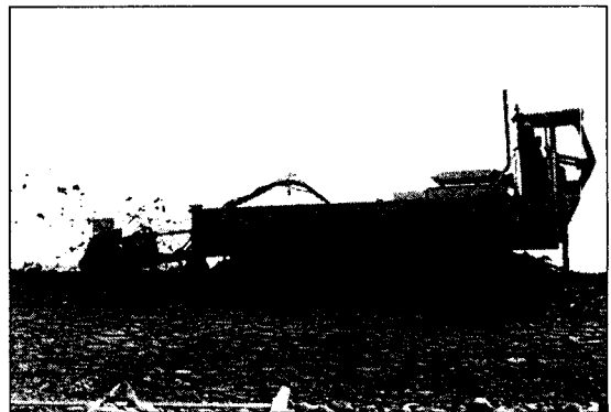
사진 3. Ditch Cutter 장착후 작업 광경
